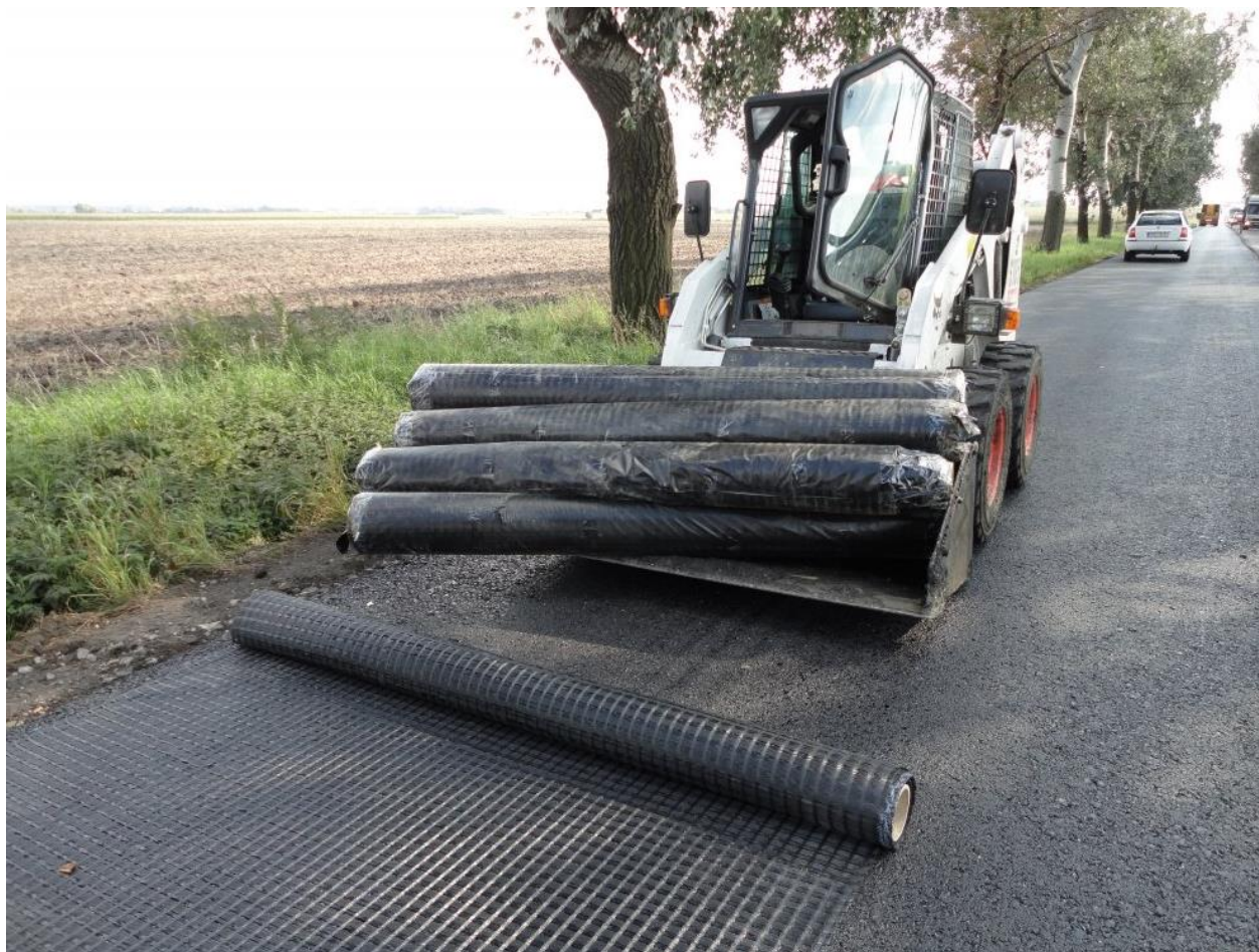
Příklad pokládky geokompositu 100 KN
